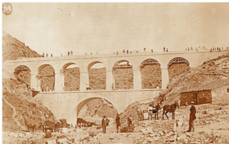
Charles Clifford - obras de construcción del Canal de Isabel II Charles Clifford - obras de construcción del Canal de Isabel II/ Canal de Isabel II construction works
