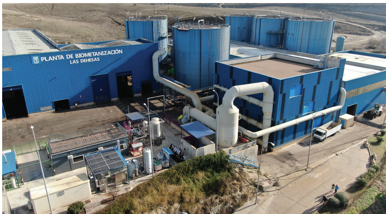
Foto: Planta de Biometanización de Las Dehesas, ubicada en el Parque Tecnológico de Valdemingómez (Madrid)
