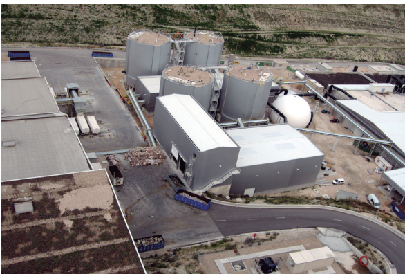
Planta de Digestión anaerobia de La Paloma
