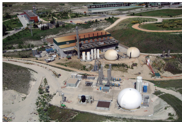
Planta de tratamiento de biogás y planta de La Galiana
