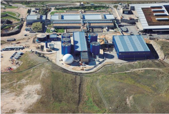
Planta de Digestión anaerobia de Las Dehesas
