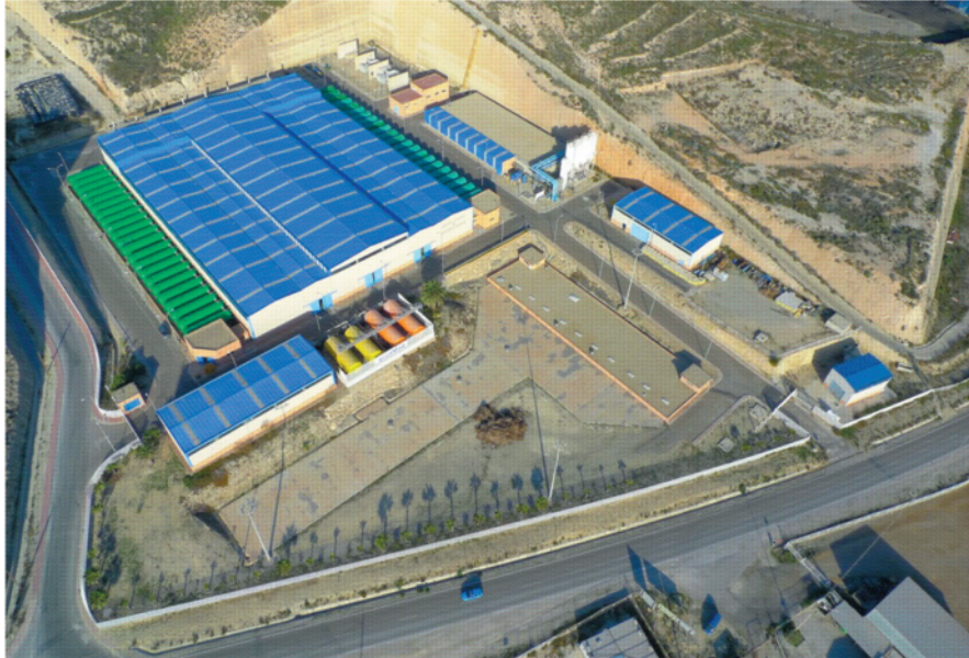
Fotografía de la planta desaladora de Carboneras (Almería). Cedita a AEDyR por GS Inima. Image of Carboneras desalination plant (Almería). Source: GS Inima
